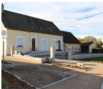
Les travaux de sécurisation dans le centre du village vont bon train.
